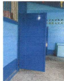
Foto 4. Cambio de puertas de las aulas y sanitarios
