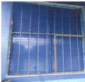
Foto 5: Sustitucion de ventana en direccion
