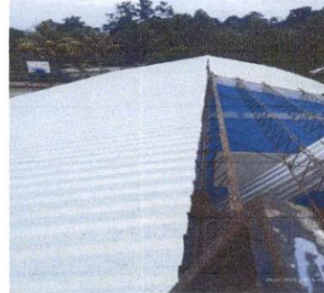
Foto 2: Cambio de techado
